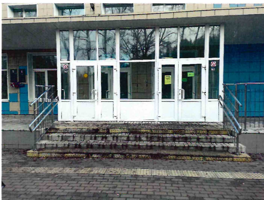
Фото № 4 Дверь (входная)
